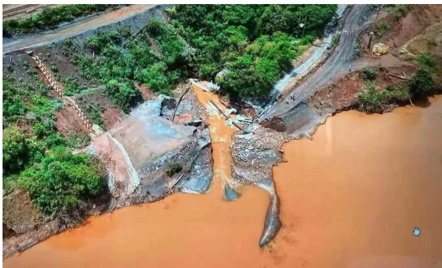
Figura 9: Cava 18 local do rompimento da estrutura de contenção Mina Fábrica -Vale S.A.
